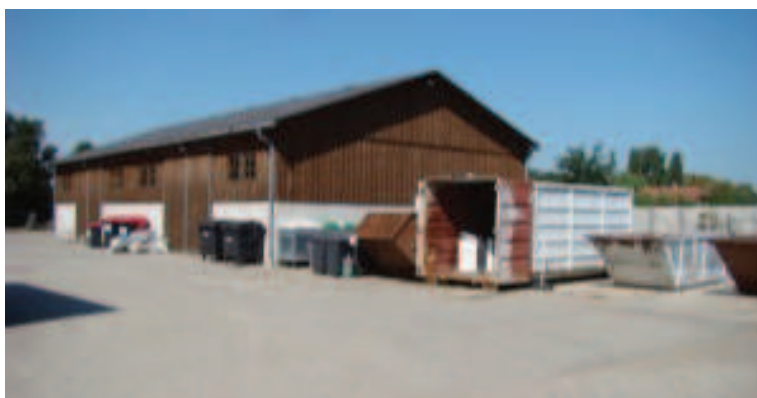
Das Sammelzentrum in Königstetten ist in die Jahre gekommen. Der Standort für ein neues Abfallsammelzentrum ist aktuell Gegenstand der (politischen) Debatte in der Gemeinde. Fotocredit: Gemeindeverband für Abfallbeseitigung in der Region Tulln ( http://tulln.abfallverband.at ).
